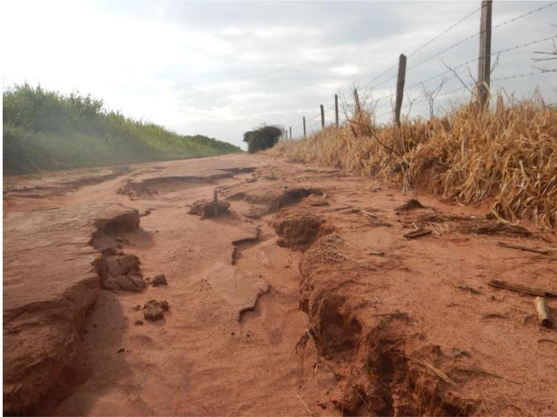
Apêndice 2.2.3.P. Feição erosiva no limite da FENP em área de transição do Latossolo para o Argissolo.
