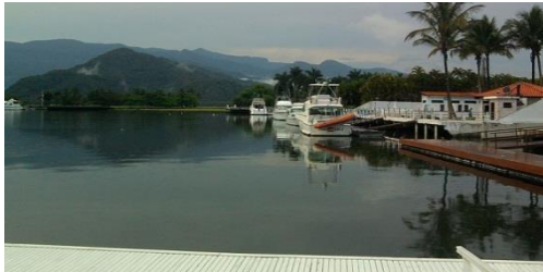
Estrutura náutica (Classe III)
