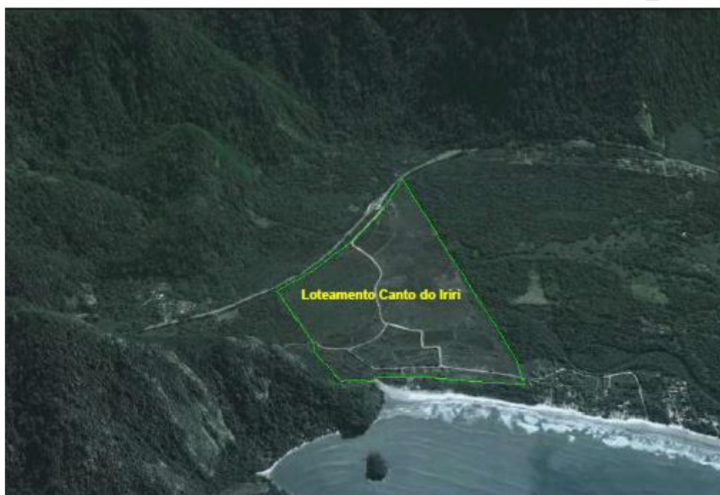
Figura 3.2.6.6.4-1 – Área onde está prevista a implantação do Loteamento Canto do Iriri.
