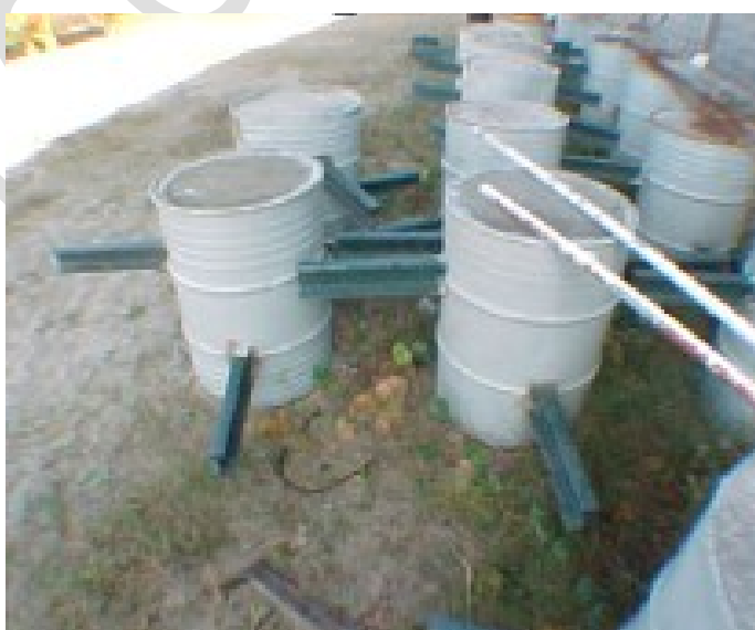
Figura 3.2.4.7-11 – Unidades anti-arrasto feitas com tambor atravessado com barras de ferro e preenchidas com concreto.
