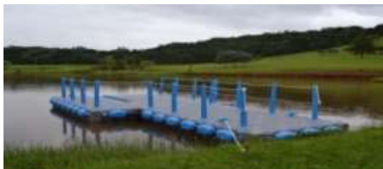
Instalação de estruturas náuticas Conforme ZEE
