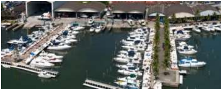
Instalação de estruturas náuticas conforme ZEE
