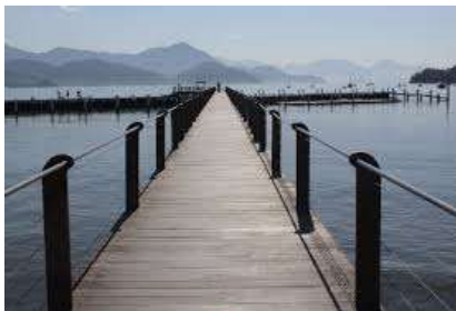
Instalação de estruturas náuticas conforme ZEE
