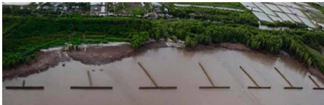
Figura 3.2.2.4.9-7 – Restauração de planícies de maré erodidas utilizando cercas de bambu em formato de T na Província de Bac Liêu (Delta Mekong, Vietnã). Houve redução da energia de ondas incidentes e da corrente de deriva.
