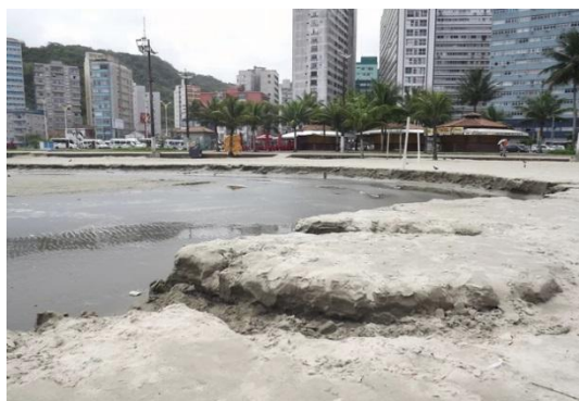
Figura 89 – Erosão nas praias de Santos. Fonte: g1.globo.com
